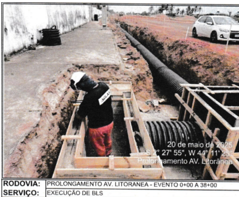
Figura 7 – Implantação de drenagem profunda (2º mês de obra)
