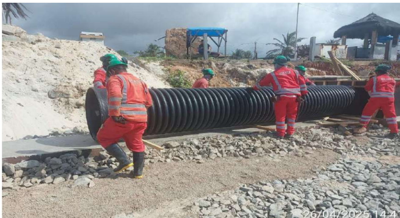
Figura 5 – Implantação dos tubos PEAD de drenagem profunda (1º mês de obra)
